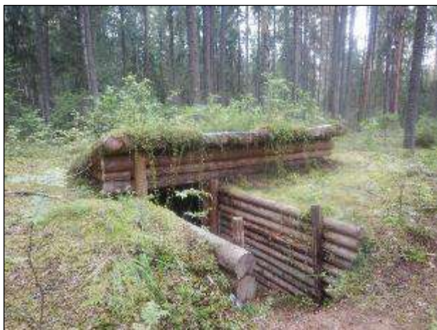
Фото 11. Общий вид землянки
